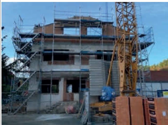
Umbauarbeiten neues Rathaus
