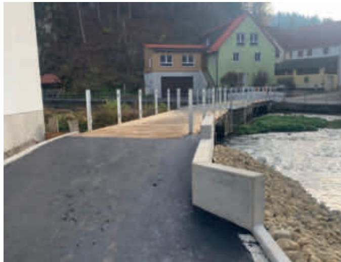
Erneuerung Brücke Nankendorf
