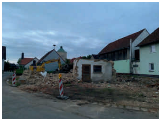
Abriss Anwesen Seelig 4
