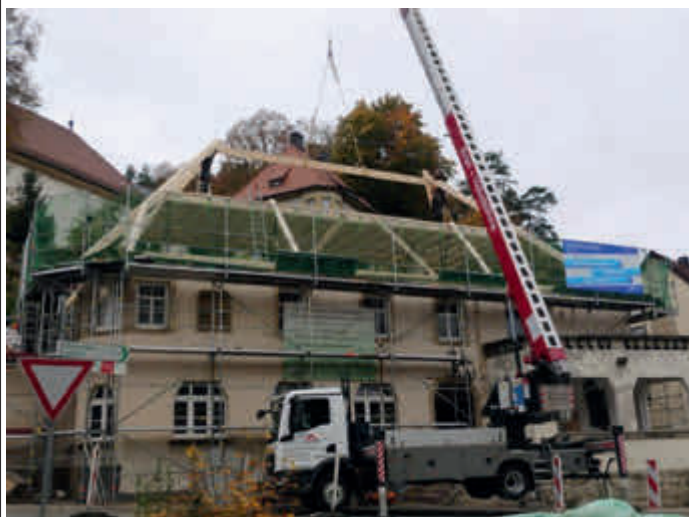
Umbau u. Sanierung ehem. Gasthaus Polsterbräu
